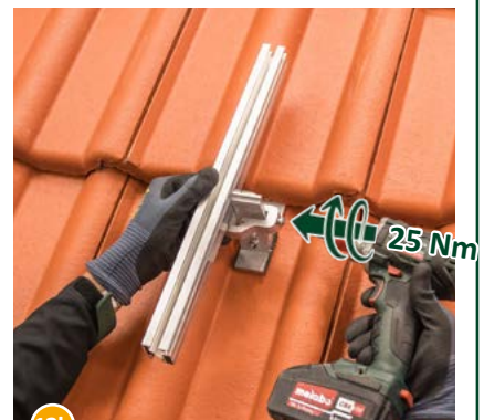
12b Die Klemmkombination mittels Schraube (25 Nm) festziehen – fertig!
