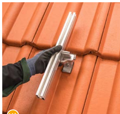
11b Die RAIL ausrichten und einhängen.
