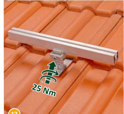
13 Die Klemmkombination mittels Schraube (25 Nm) festziehen – fertig!
